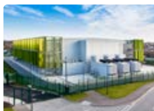
KAO – data centre fitout
